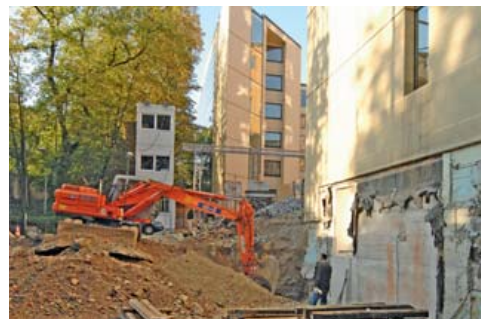
Bagger im Einsatz: Abbruch- und Aushubarbeiten an der Ostpforte.
