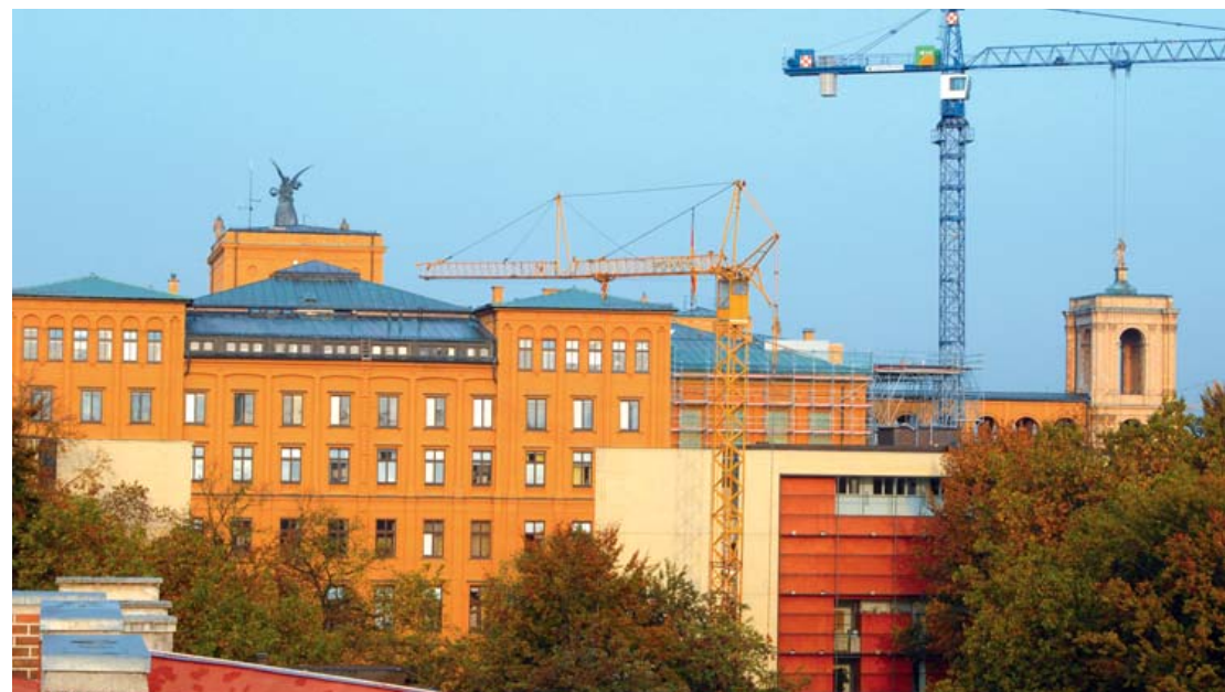
Baukräne über den Dächern des Maximilianeums. /Fotos Poss/Stehle
